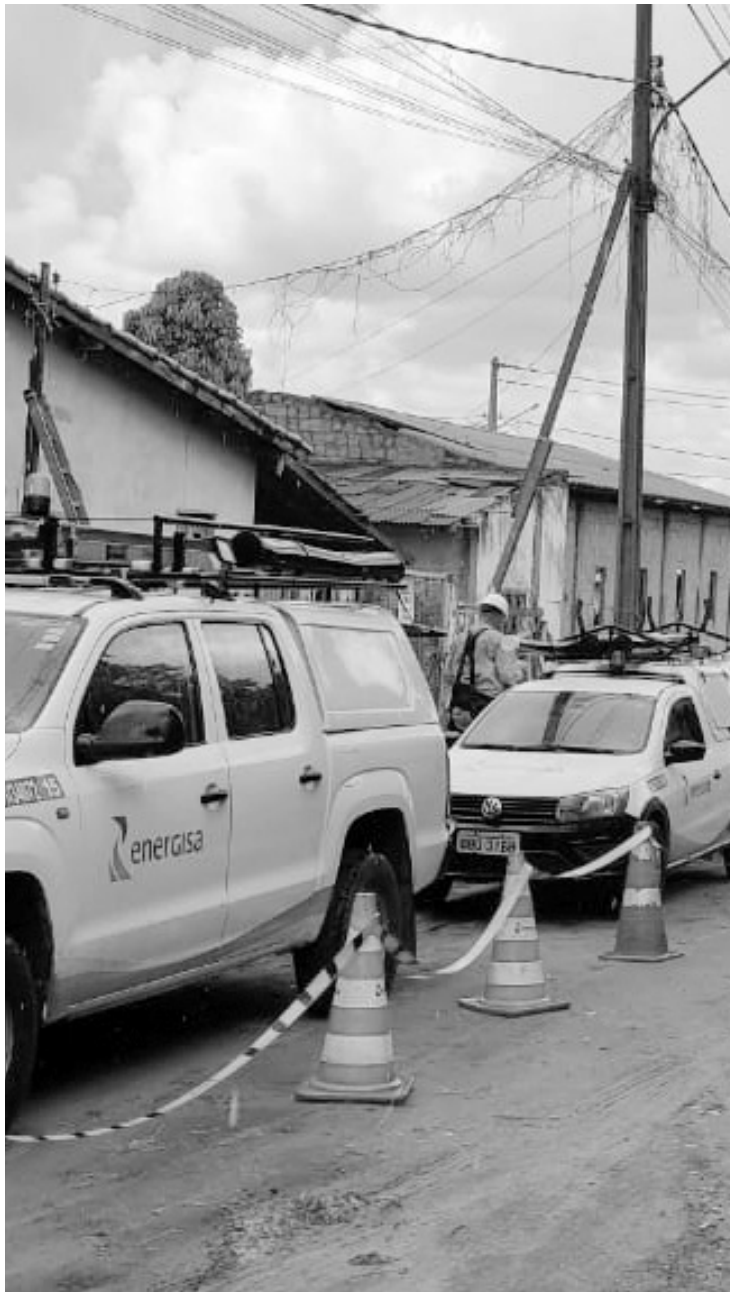
No imóvel a suspeita foi confirmada
