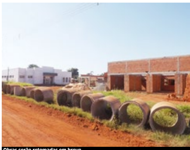
Obras serão retomadas em breve
