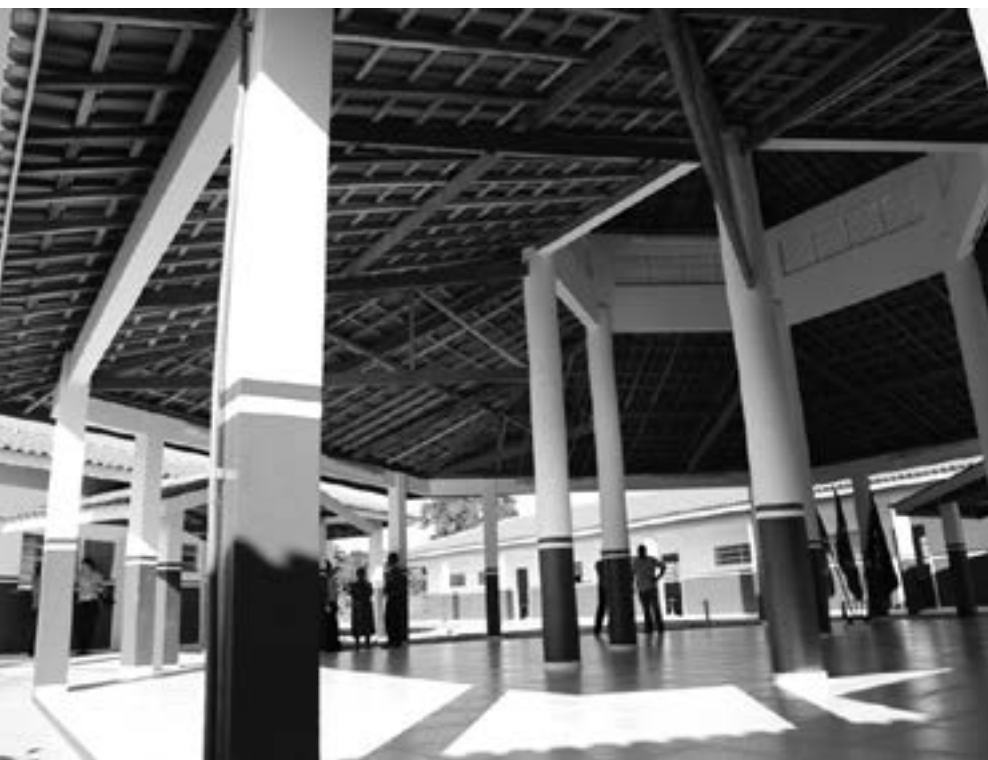
A nova escola tem seis salas de aula, área para recreação, refeitório, secretaria e banheiros
