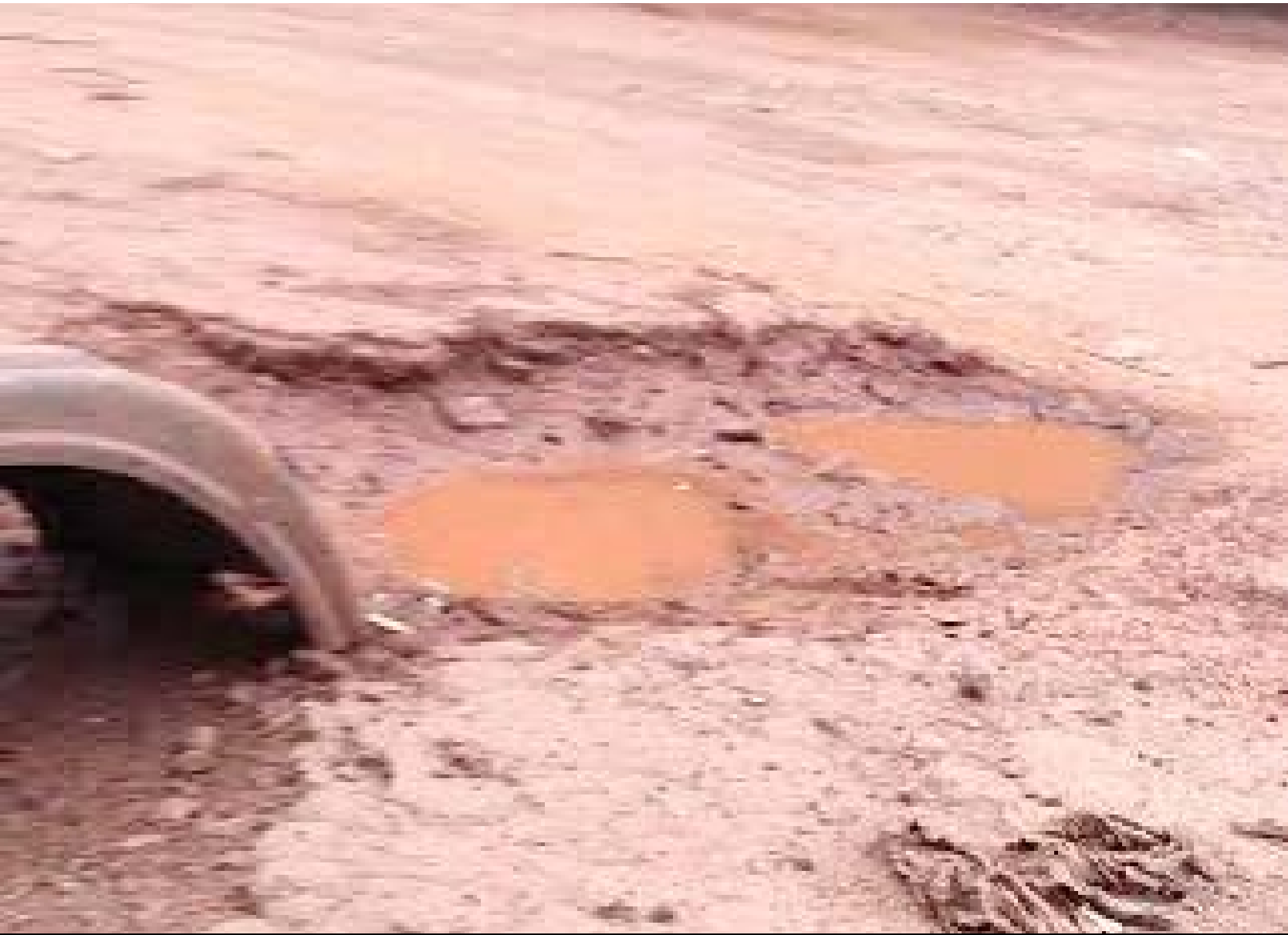
Fotos enviadas por um leitor mostra estado crítico do trecho
