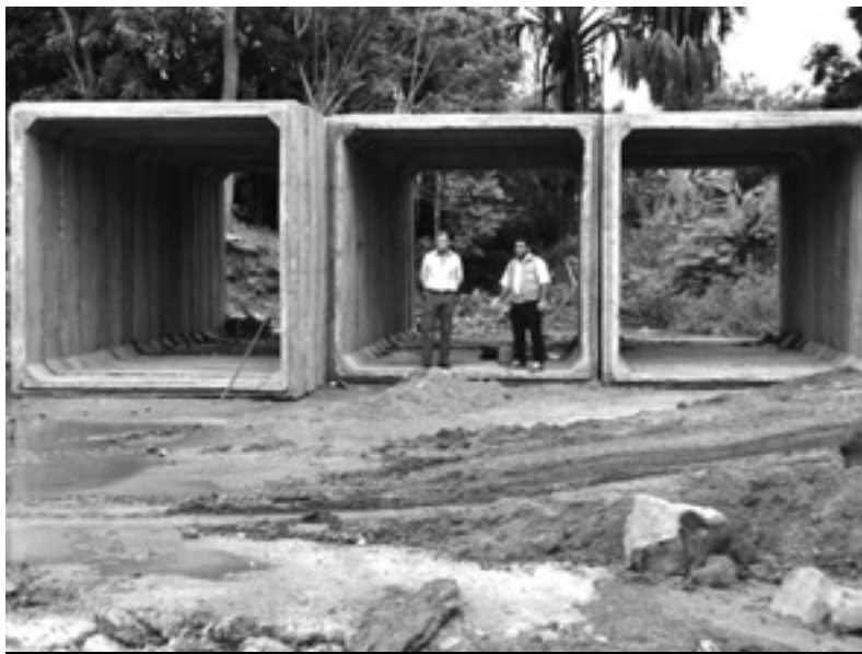
Diversas obras foram executadas ao longo do ano que passou
