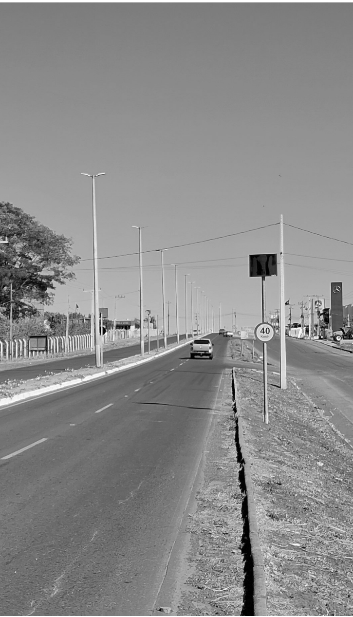
LOMBADAS ELETRÔNICAS INSTALADAS
