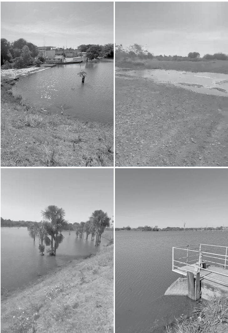
REPRESAS DA ETA
