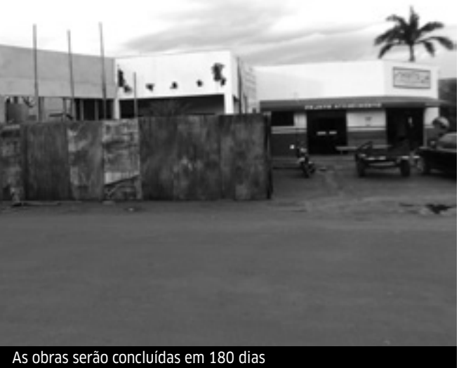
As obras serão concluídas em 180 dias
