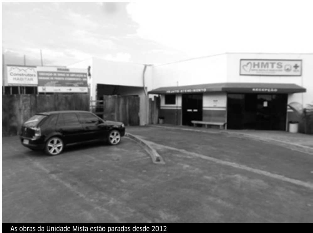
As obras da Unidade Mista estão paradas desde 2012
