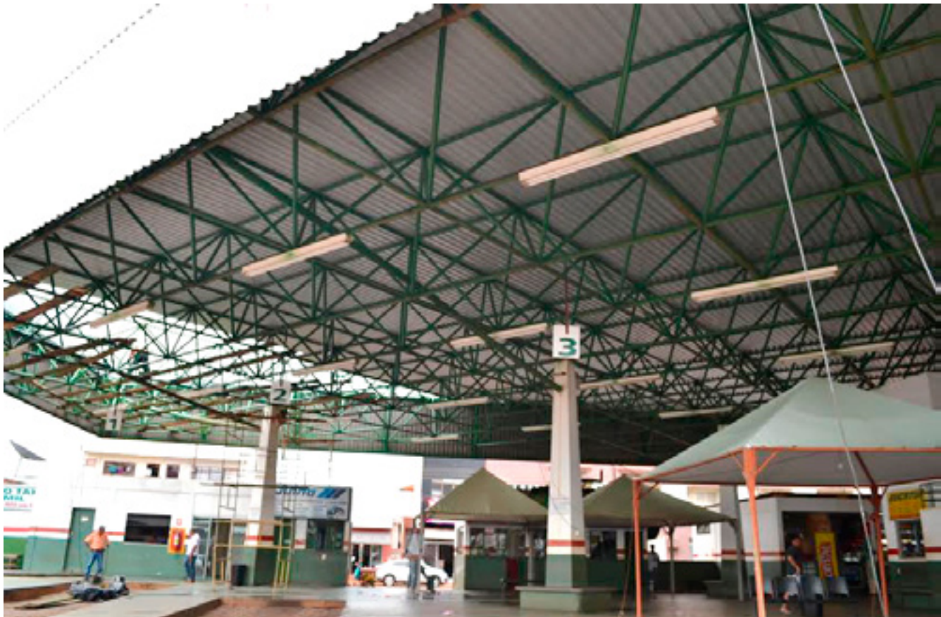
Além da cobertura, obra consiste em reparos na parte elétrica e pintura do terminal
