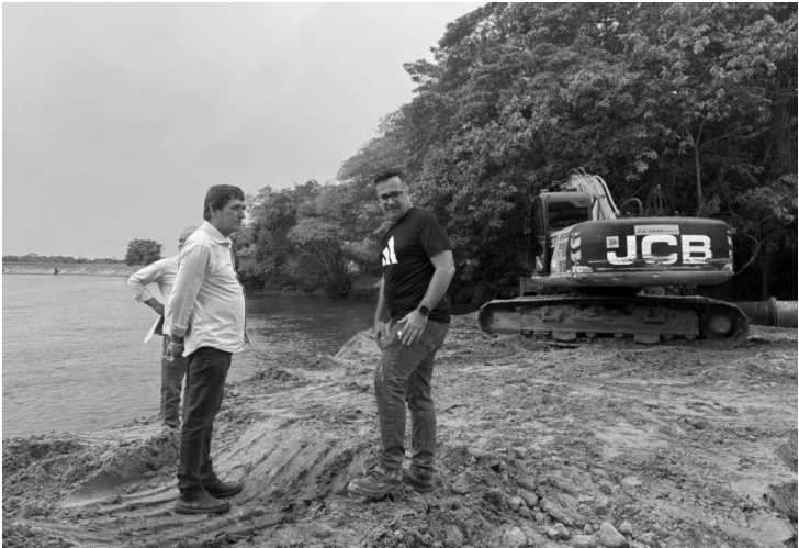
PREFEITO FISCALIZANDO OS TRABALHOS
