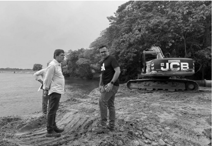
PREFEITO FISCALIZANDO OS TRABALHOS
