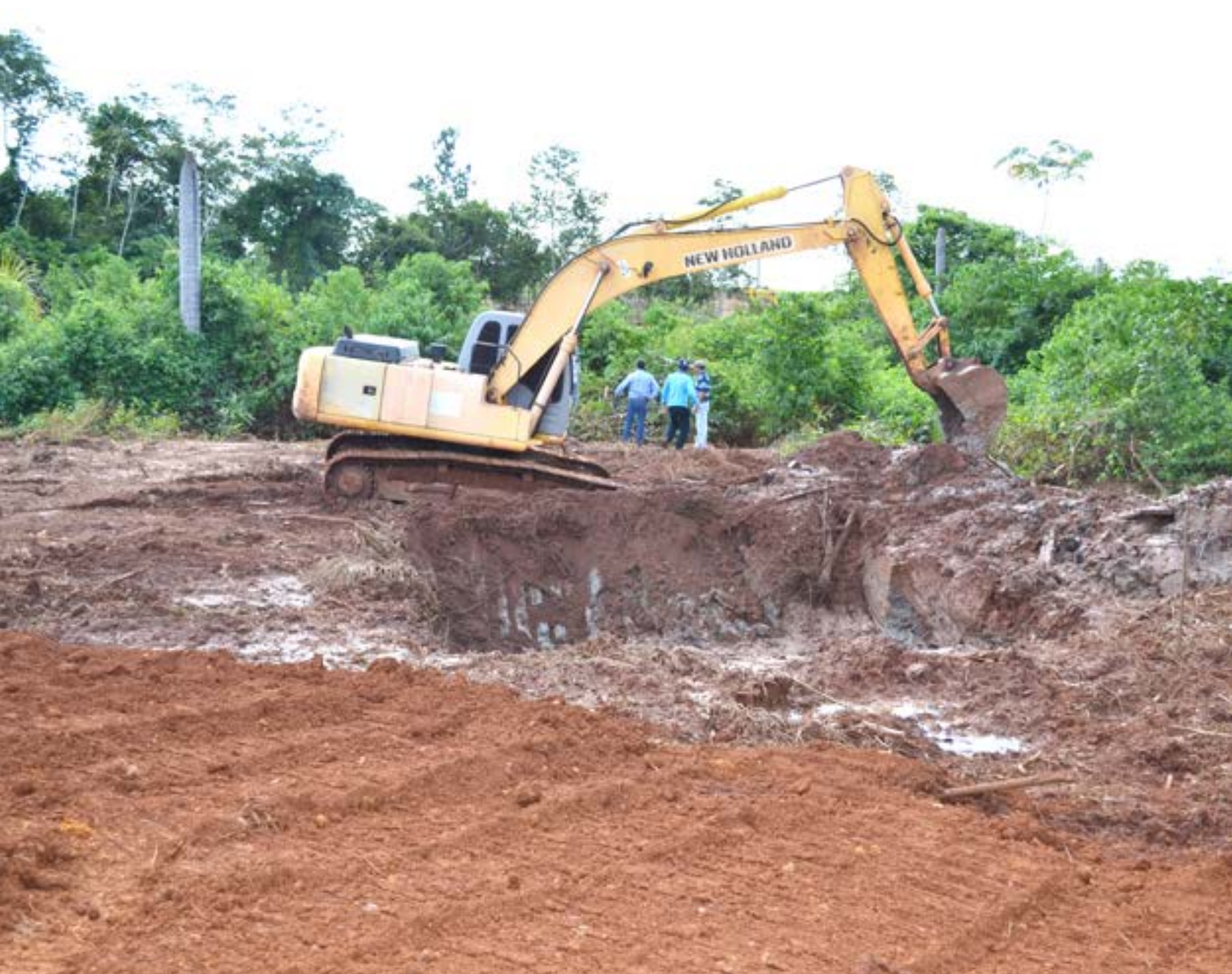
A obra será concluída nos próximos 20 dias
