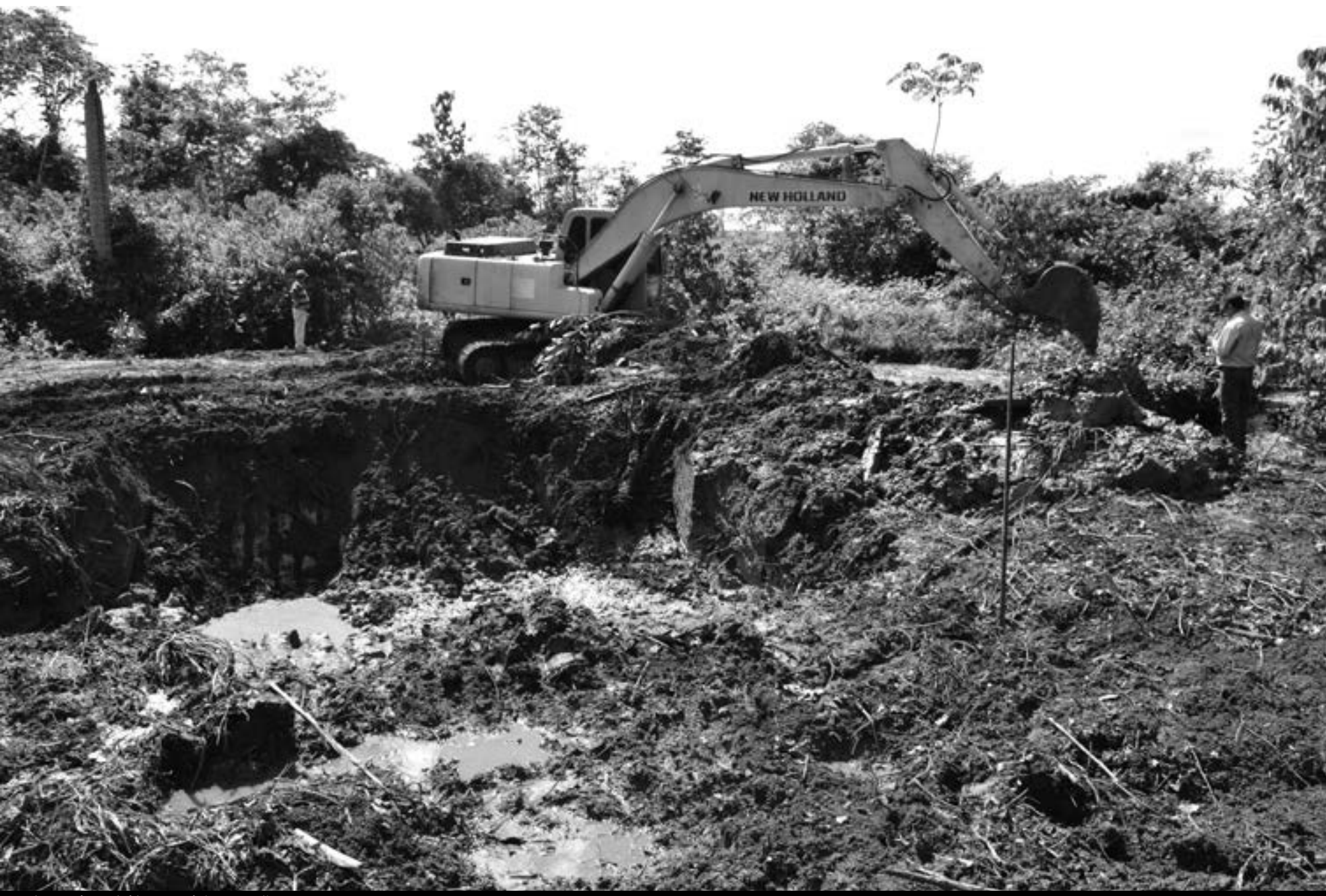
A obra será concluída nos próximos 20 dias
