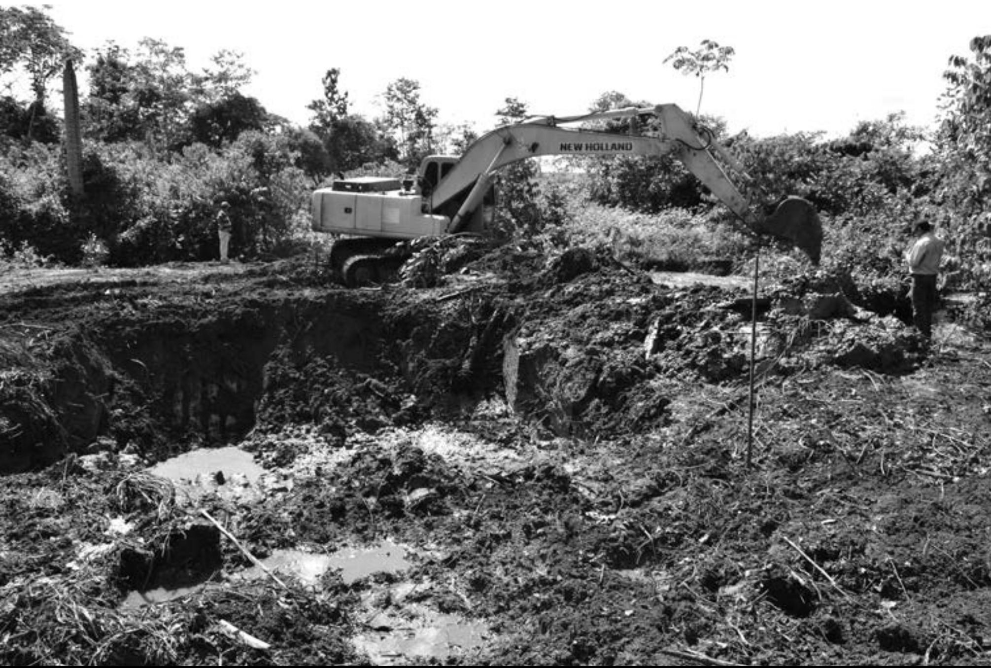
A obra será concluída nos próximos 20 dias
