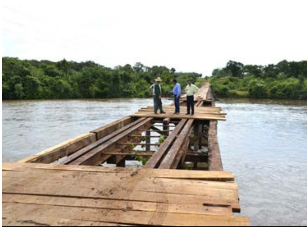
A ponte tem 132 metros de extensão e será totalmente recuperada
