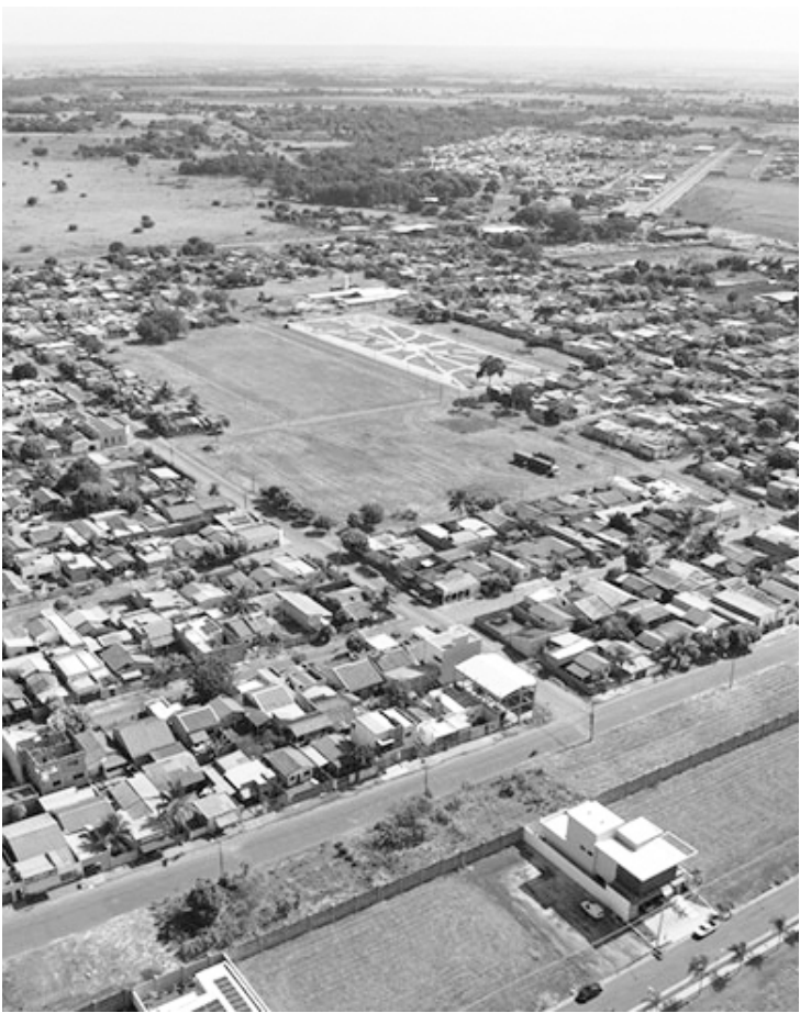
OBRAS NO BAIRRO MORADA DO SOL
