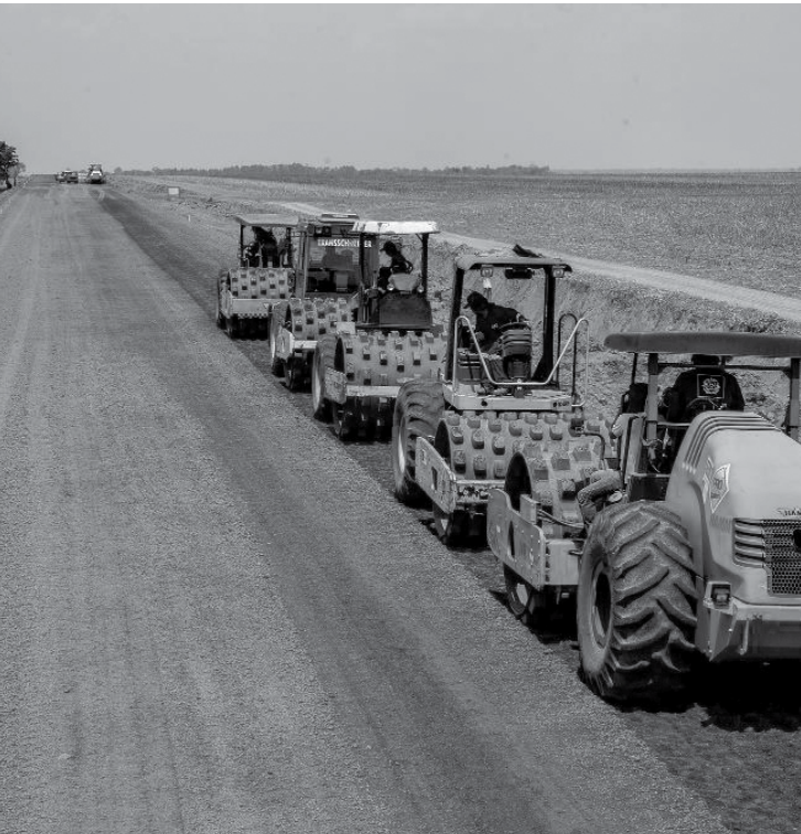
OBRAS NA MT-220
