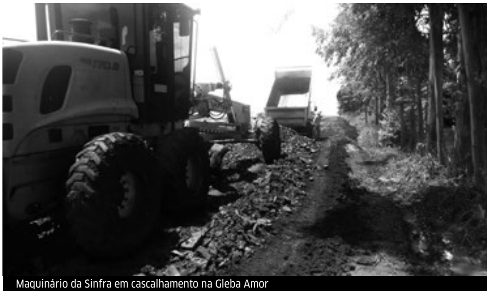
Maquinário da Sinfra em cascalhamento na Gleba Amor
