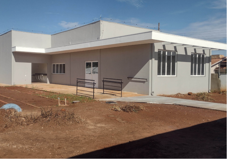
OBRAS ESTÃO SENDO FINALIZADAS
