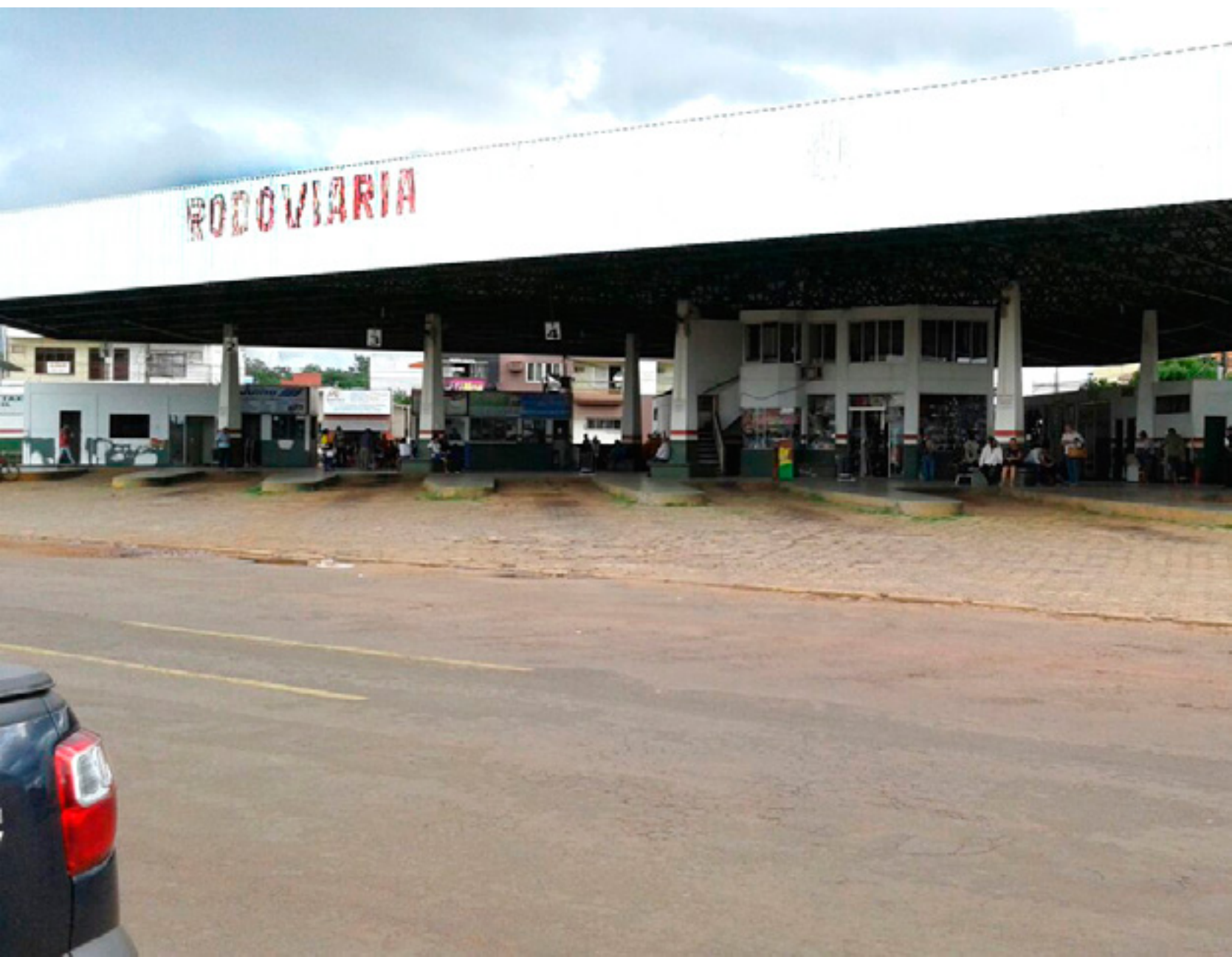
Obras continuam na estrutura física da rodoviária
