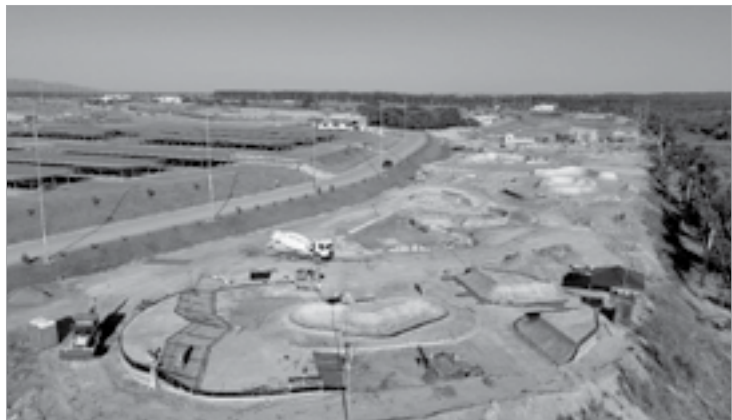
PISTA EM CONSTRUÇÃO NO PARQUE
