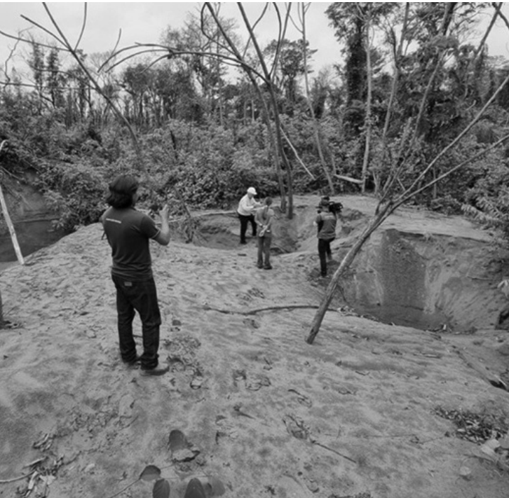
EROSÃO PROVOCOU COLAPSO DO SOLO
