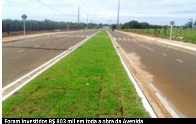
Foram investidos R$ 803 mil em toda a obra da Avenida
