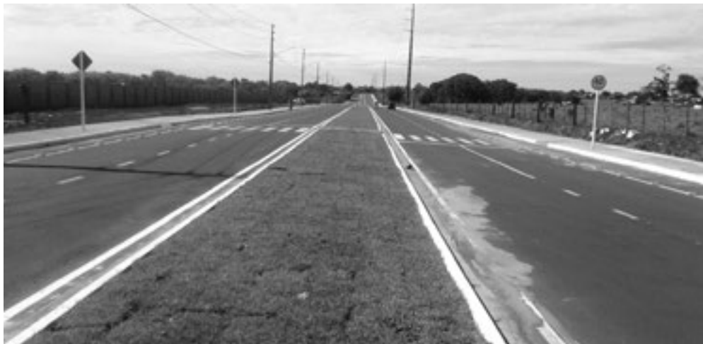
Foram investidos R$ 803 mil em toda a obra da Avenida
