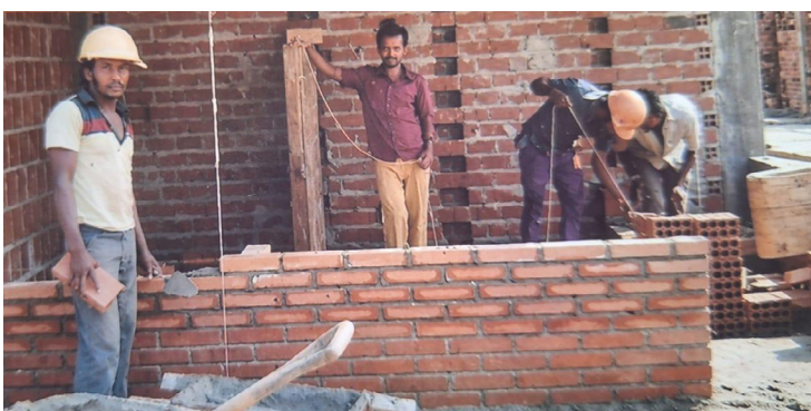
BELMIRO CONSTRUINDO ESCOLAS DO MUNICÍPIO
