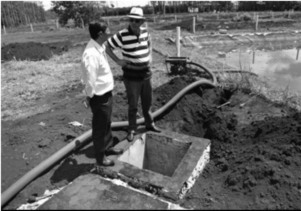
Wesley Torres vistoriou as obras acompanhado do Prefeito Fábio Junqueira
