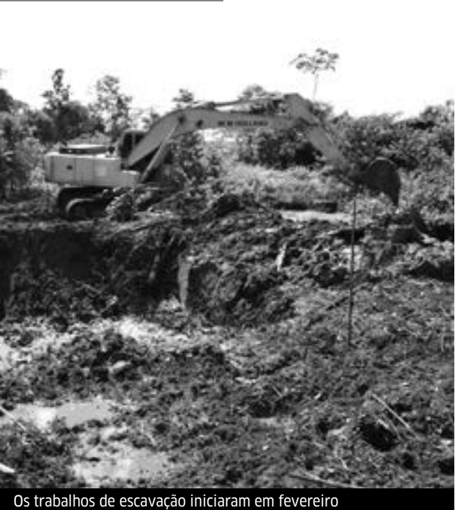
Os trabalhos de escavação iniciaram em fevereiro
