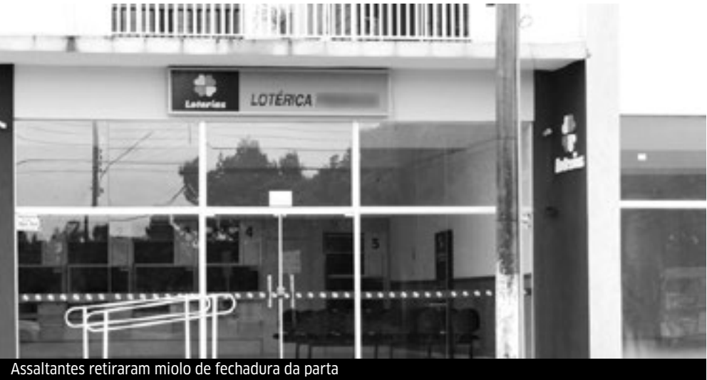
Assaltantes retiraram miolo de fechadura da porta
