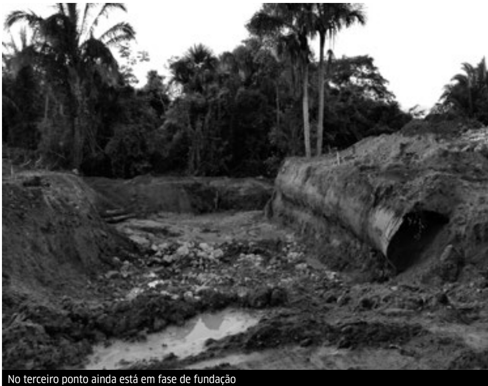
No terceiro ponto ainda está em fase de fundação
