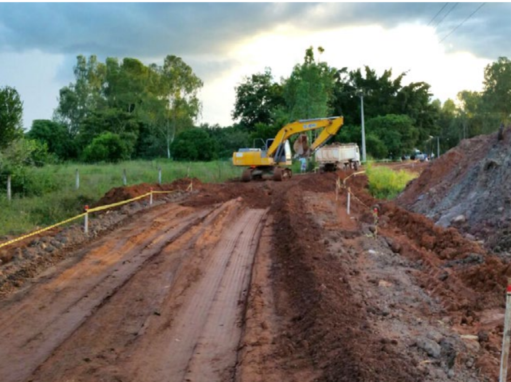
Trabalhos estão em fase de finalização da terraplanagem
