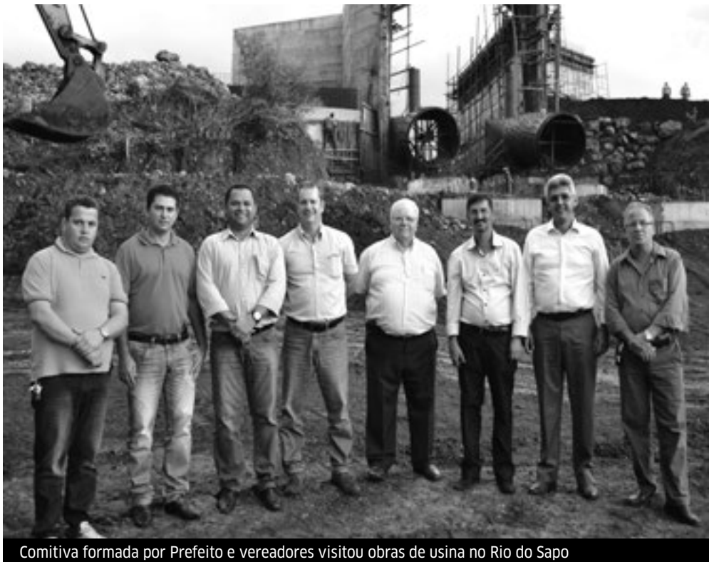
Comitiva formada por Prefeito e vereadores visitou obras de usina no Rio do Sapo
