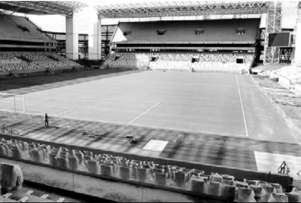
Arena Pantanal está com 97% das obras prontas
