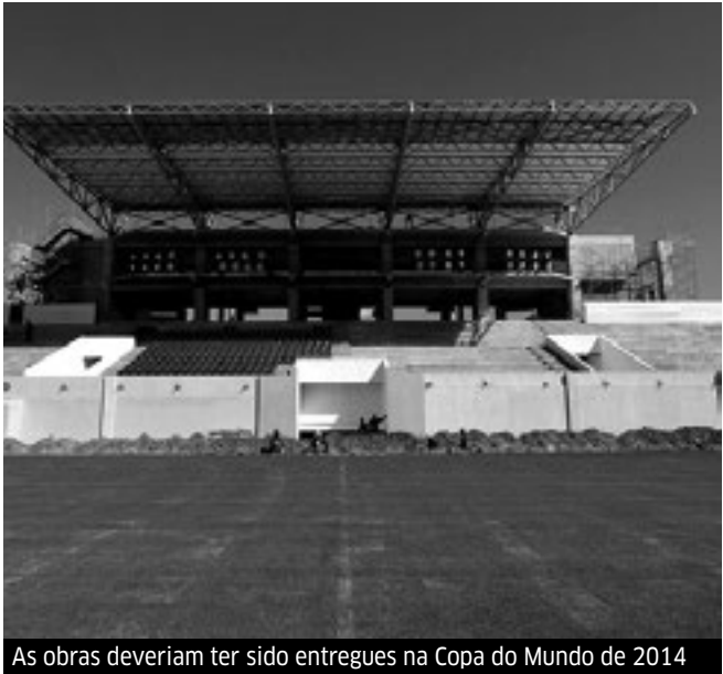
As obras deveriam ter sido entregues na Copa do Mundo de 2014
