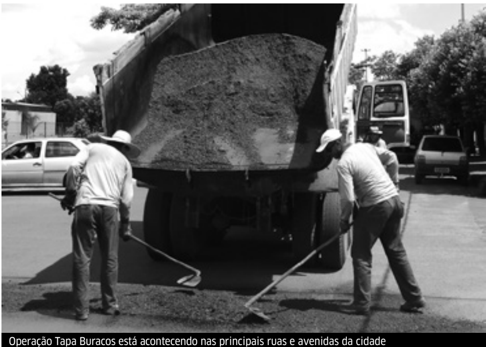
Operação Tapa Buracos está acontecendo nas principais ruas e avenidas da cidade
