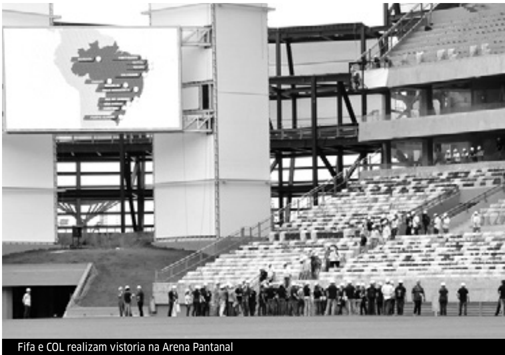
Fifa e COL realizam vistoria na Arena Pantanal
