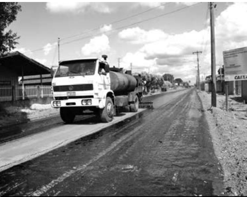
Serão asfaltados 8.227,25 metros quadrados na rua Paraná
