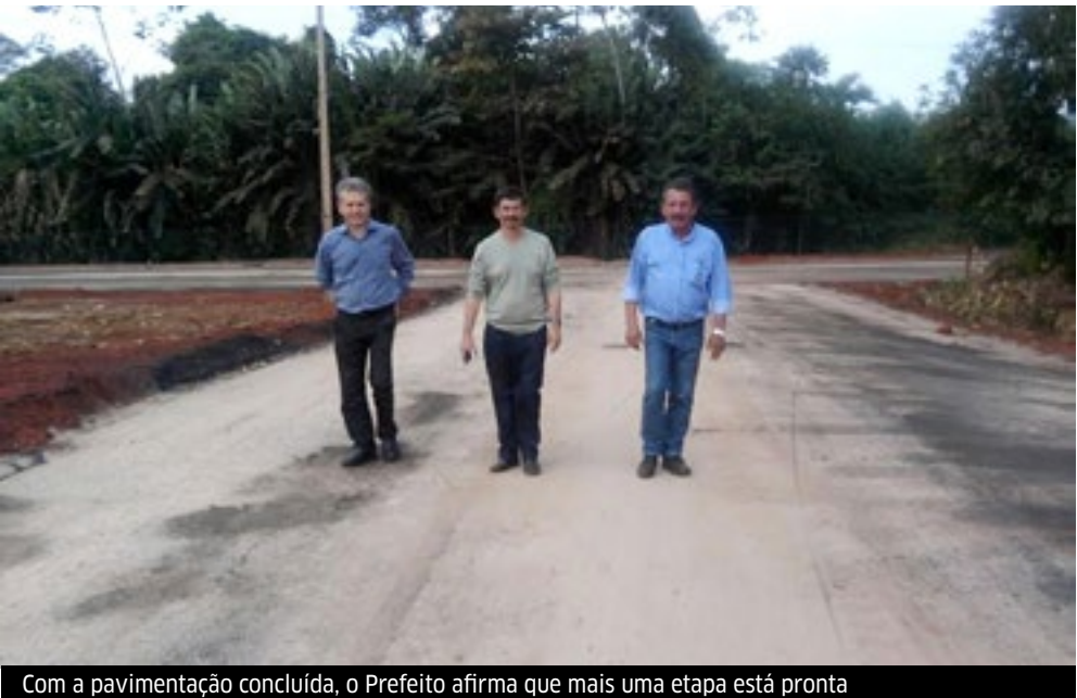
Com a pavimentação concluída, o Prefeito afirma que mais uma etapa está pronta
