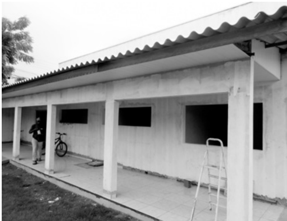
As obras no Jardim Tarumã também estão em fase de acabamento
