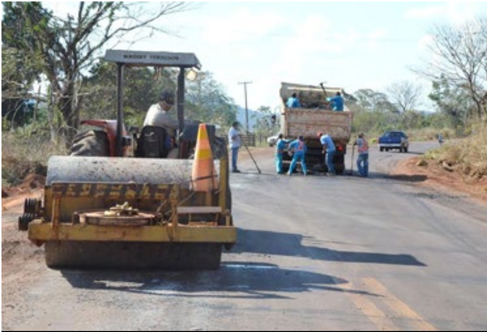
O material asfáltico foi o suficiente para consertar aproximadamente 10 quilômetros de rodovia
