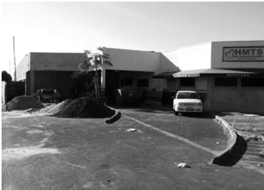
A obra está orçada inicialmente em R$ 2.599.137,90
