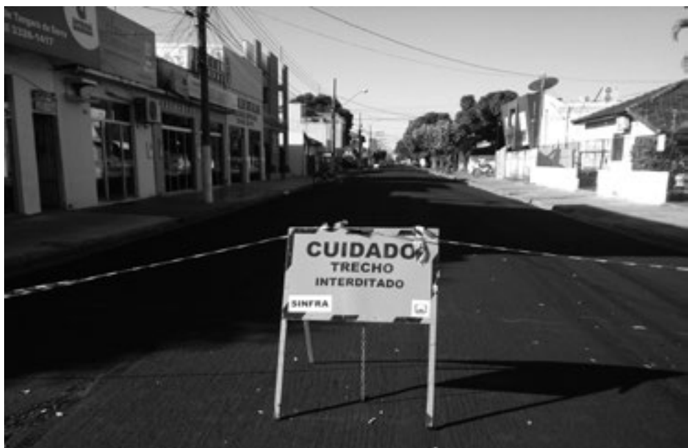
Rua Antônio Hortolani passou pelo processo de revitalização com lama asfáltica
