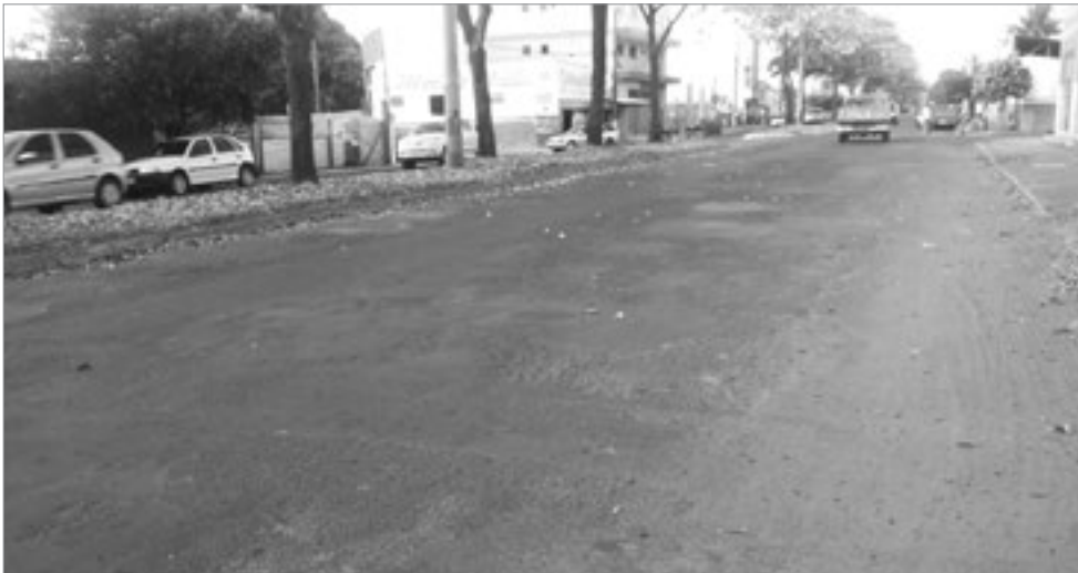
Um novo asfalto será feito entre a rotatória que cruza a Rua 01 com a Avenida Mato Grosso
