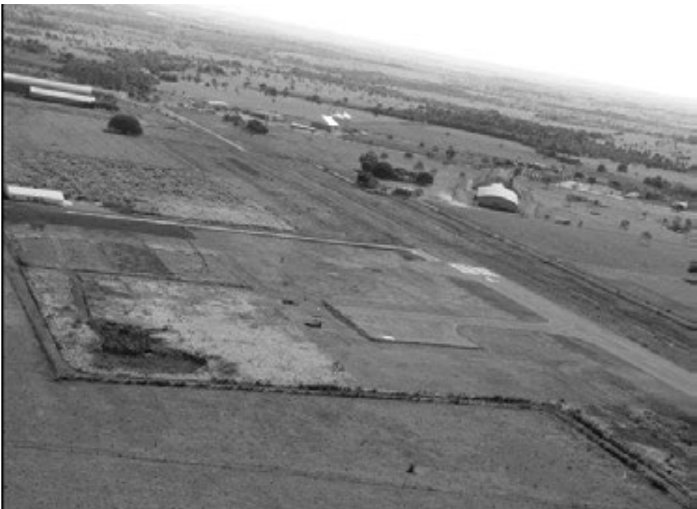
Duas obras serão executadas no Aeroporto de Tangará nos próximos três meses
