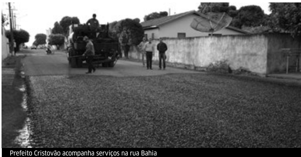
Prefeito Cristovão acompanha serviços na rua Bahia
