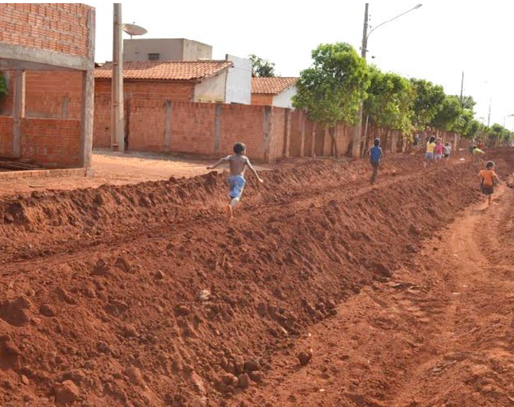
Obras foram iniciadas no último final de semana
