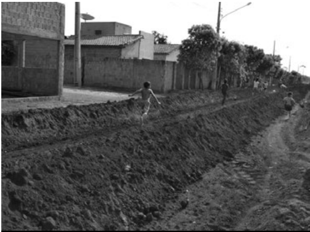
Obras foram iniciadas no último final de semana
