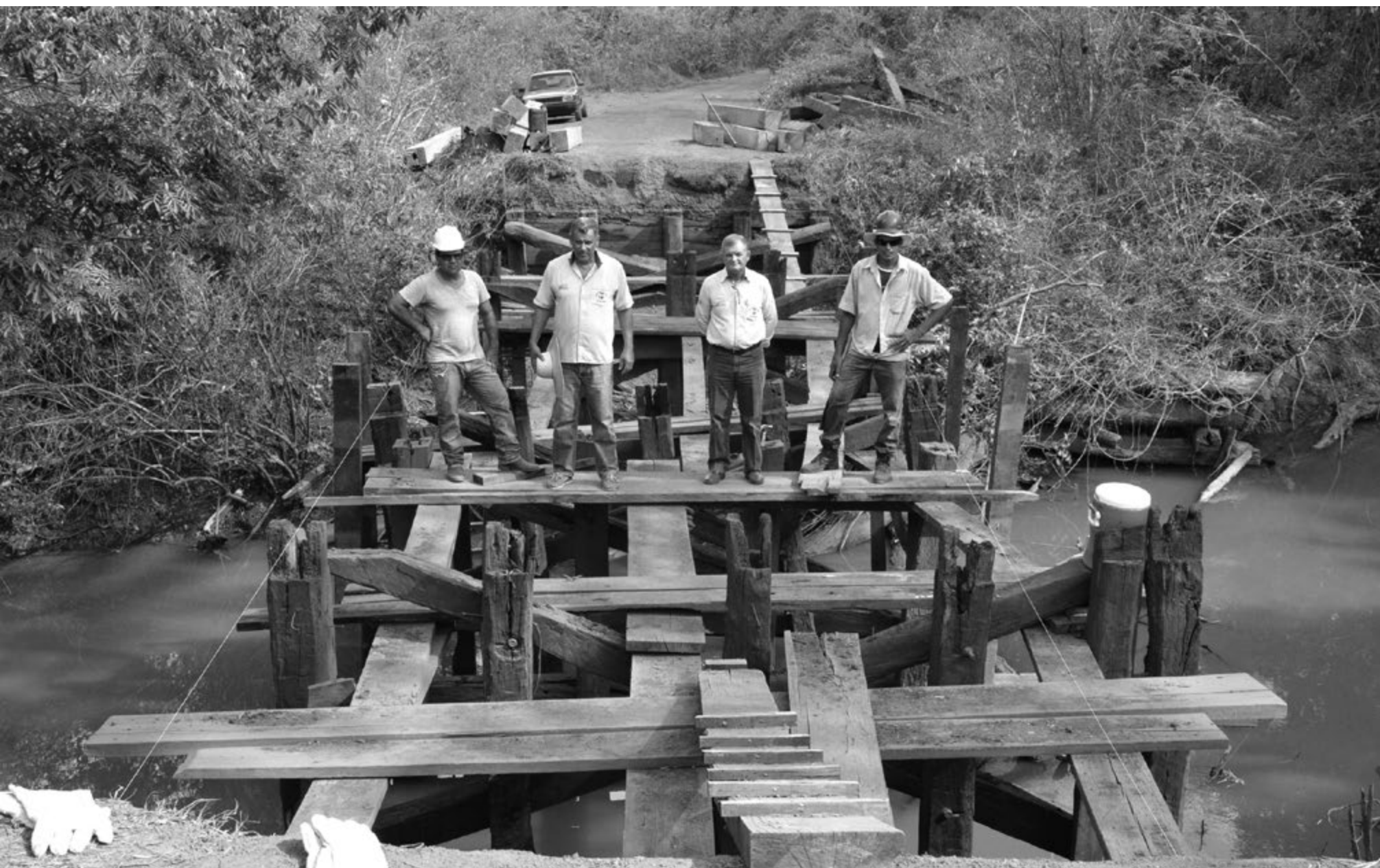
Os serviços de construção e recuperação das pontes foram iniciados na última semana
