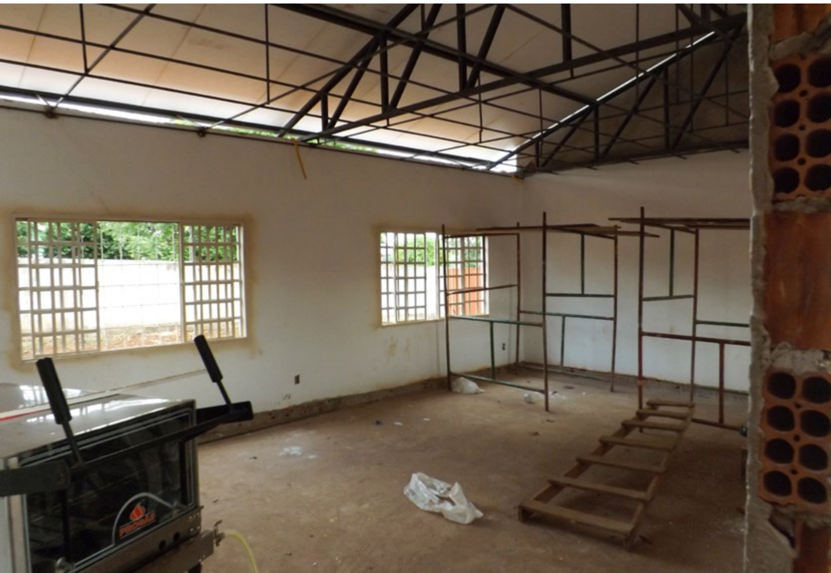
Obra prevê duas novas salas de aula, uma cozinha e amplo refeitório
