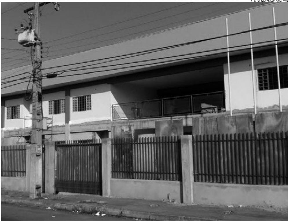
Previsão inicial era que a obra finalizasse no final de setembro desse ano
