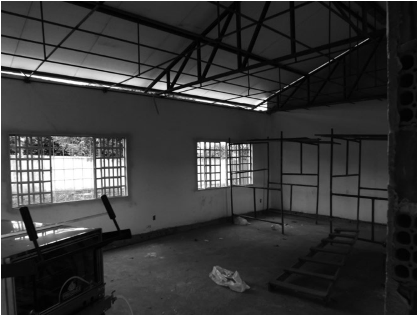
Obra prevê duas novas salas de aula, uma cozinha e amplo refeitório
