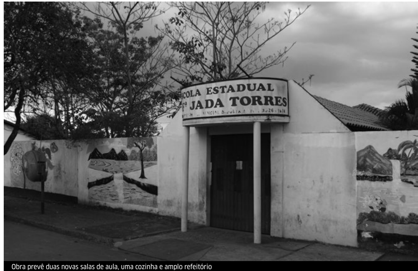
Obra prevê duas novas salas de aula, uma cozinha e amplo refeitório
