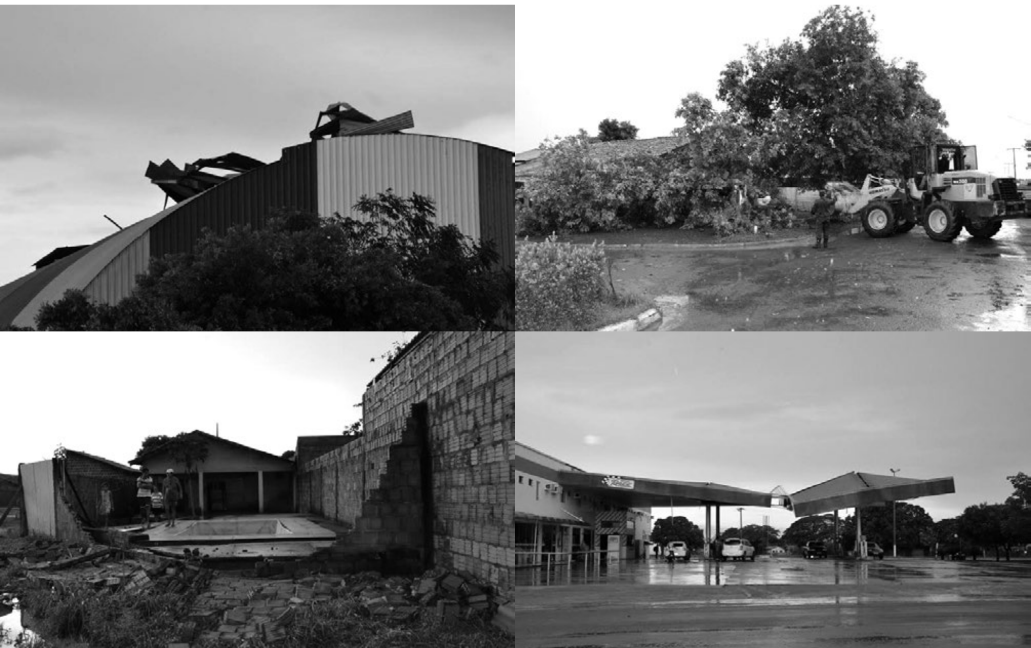
Chuva aliada a forte vento causou destelhamento de casas e escolas, desabamento de muros e derrubou árvores sobre ruas e avenidas
