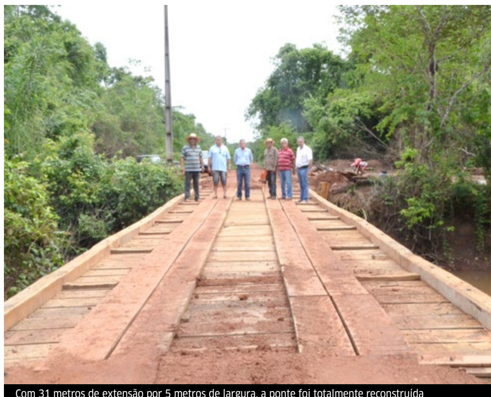
Com 31 metros de extensão por 5 metros de largura, a ponte foi totalmente reconstruída
